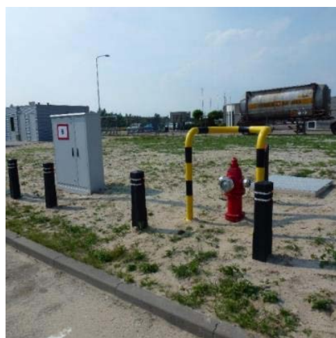
Figuur B1.3. Een gesloten brandput met een vaste onderwaterpomp en een buiten-opstellingkast voor de pompbediening. Boven: werktekening. Onder: voorbeeld van een gerealiseerde put en de bedieningskast.
