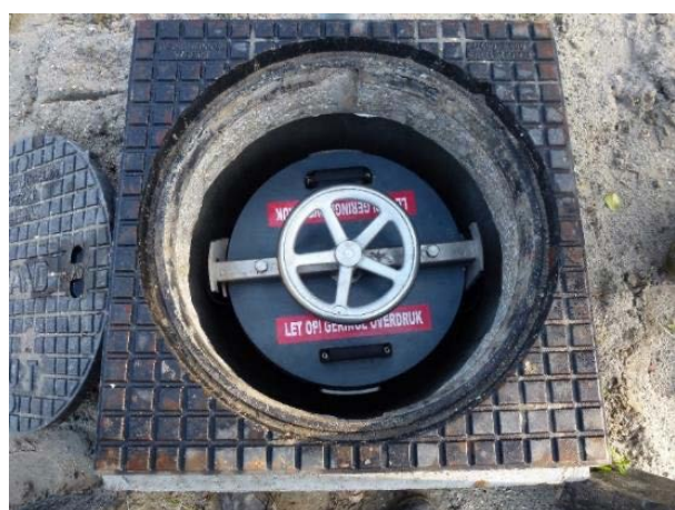
Figuur B1.4. Een open brandput die zo is uitgevoerd dat er door de brandweer van bovenaf een zuigslang of dompelpomp kan worden ingehangen. Linksonder: werktekening. Rechtsboven: werktekening, detail bronkop. Linksonder en rechtsonder: voorbeelden van een gerealiseerde put.
