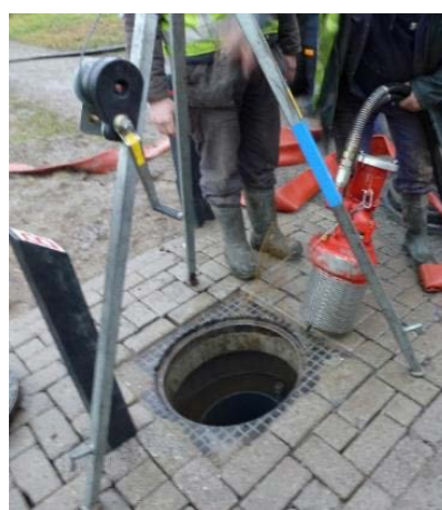
Figuur B1.4. Een open brandput die zo is uitgevoerd dat er door de brandweer van bovenaf een zuigslang of dompelpomp kan worden ingehangen. Linksonder: werktekening. Rechtsboven: werktekening, detail bronkop. Linksonder en rechtsonder: voorbeelden van een gerealiseerde put.
