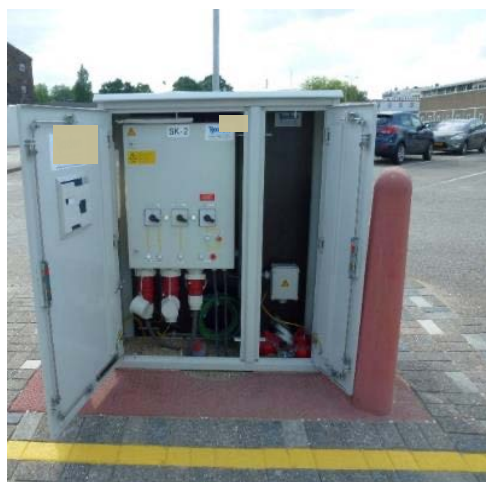
Figuur B1.3. Een gesloten brandput met een vaste onderwaterpomp en een buiten-opstellingkast voor de pompbediening. Boven: werktekening. Onder: voorbeeld van een gerealiseerde put en de bedieningskast.
